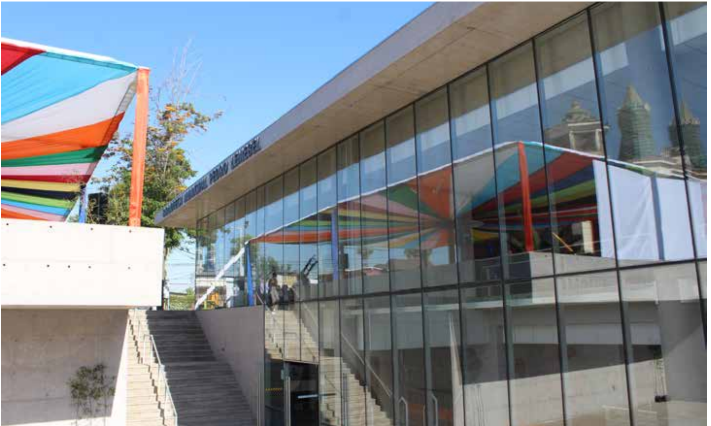
Vista desde explanada de La Biblioteca Municipal Pedro Lemebel.
